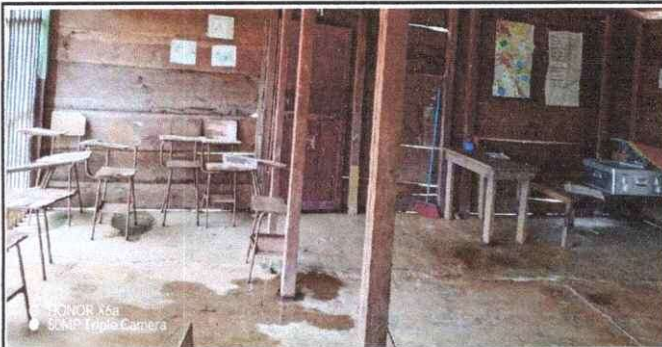
Foto 5: REPARACION DE PISO DE CONCRETO
