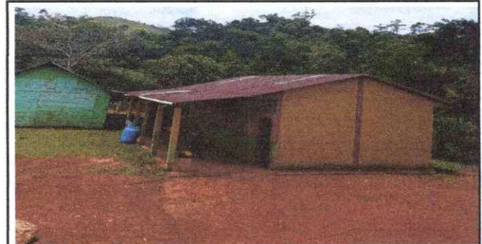
Foto 6: REHABILITACION DE PAREDES EN MODULO 1
