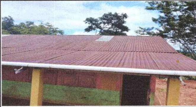
Foto 1: CAMBIO DE CUBIERTA DE TECHO MODULO 1
