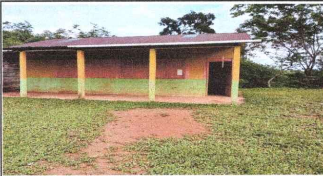
Foto 3: SUSTITUCION DE VENTANAS
