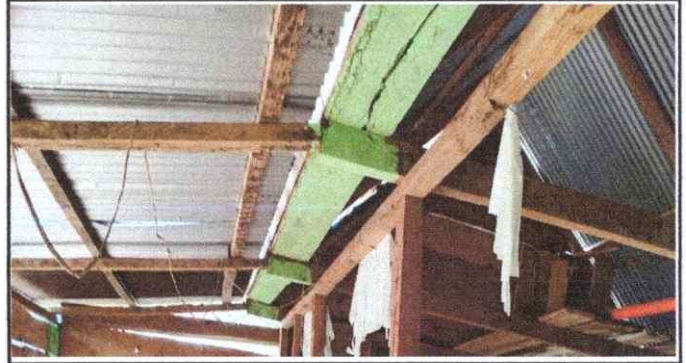
Foto 2: CAMBIO DE ESTRUCTURA DE TECHO MODULO 1
